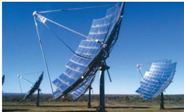
*Slika 3. Solarna elektrana s paraboličkim solarnim tanjurima<sup>[16]</sup>*
