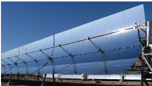
Slika 5. Solarna elektrana s paraboličkim kolektorima [15]
