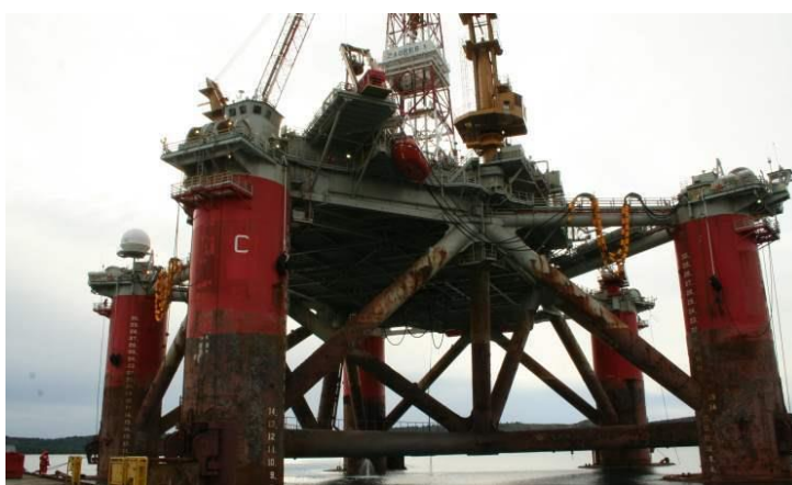
Slika 17. Naftna platforma u brodogradilištu u Trogiru (izvor: https://trogirportal.info/trogir/naftna-platforma-zagreb-1-do-kraja-tjedna-krece-za-libiju )
