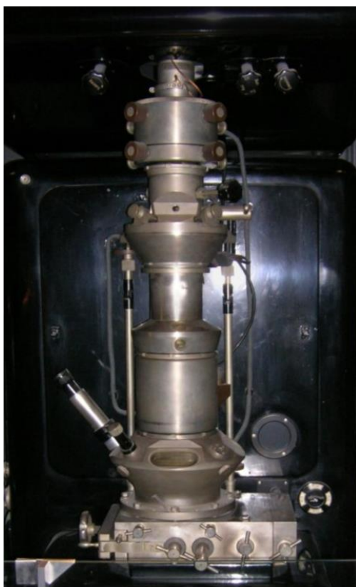
Slika 1 Prototip elektronskog mikroskopa 1933. godine (Lalchandama, 2020)
